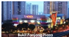
Bukit Panjang Plaza
