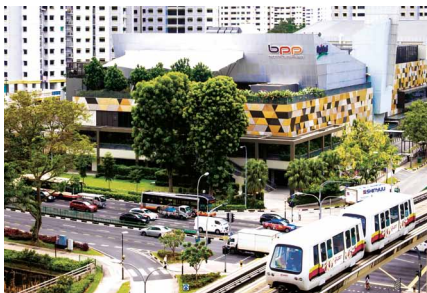
10 Bukit Panjang Plaza
